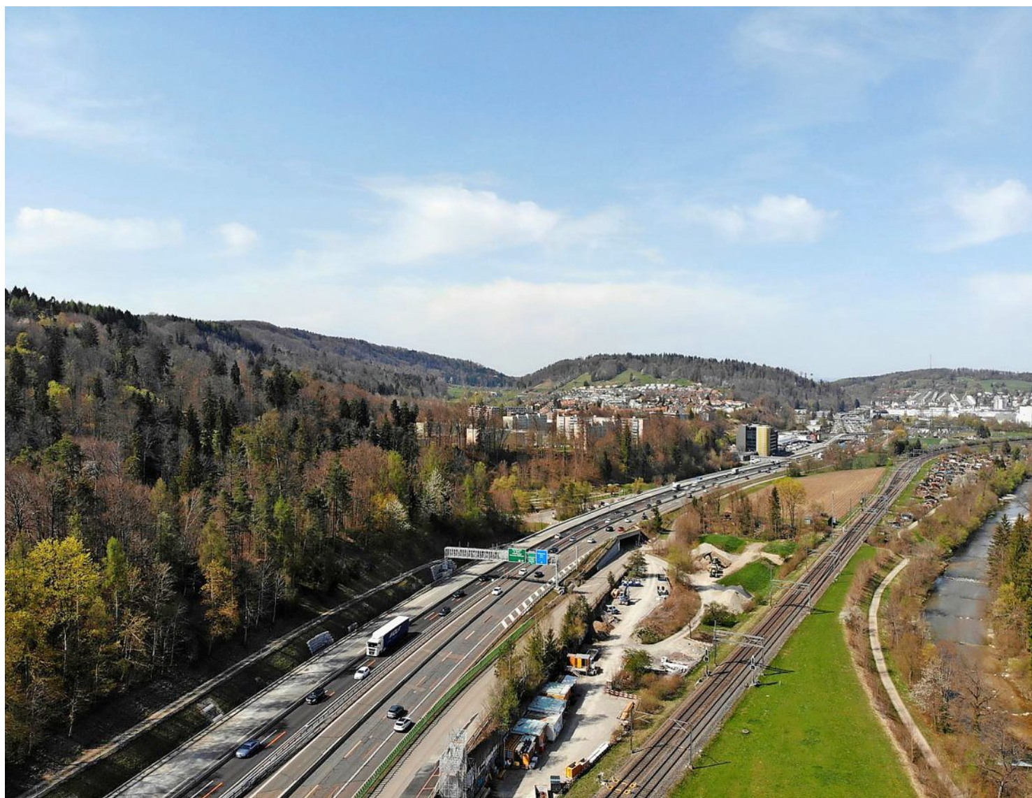
In diesem Gebiet tauchen dereinst die Gleise des Brüttener Tunnels aus dem Boden. Etwas weiter stadteinwärts soll die Autobahn abtauchen – wenn es nach dem Winterthurer Stadtrat geht. Foto: Madeleine Schoder
